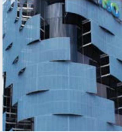
El revestimiento Screenpanel N permite dar un acabado de una sola piel a las fachadas, a partir de paneles dinámicos colocados en sentido horizontal en más de 60 colores para escoger. Se pueden obtener diseños y figuras a partir de punzonados personalizados, logrando translucidez en el material.
