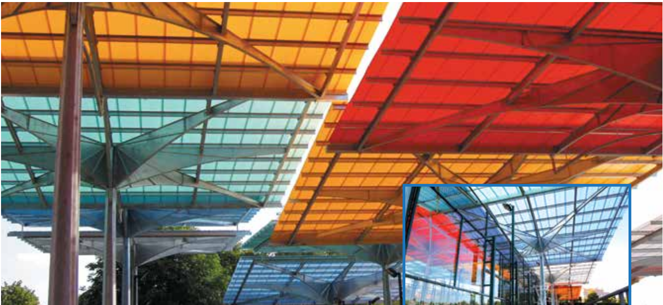
Padels Mendizorrotza, España | Sistema de cubiertas de Danpal® Arquitecto: Ramón Ruiz Cuevas
